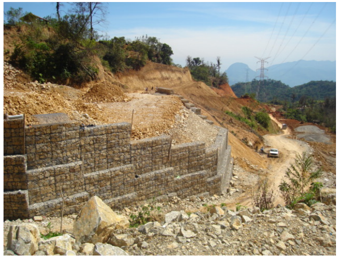
Durante la obra
