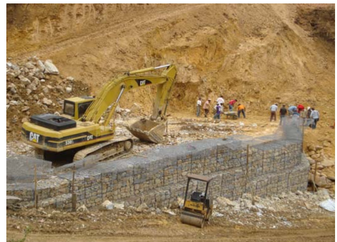
Durante la obra
