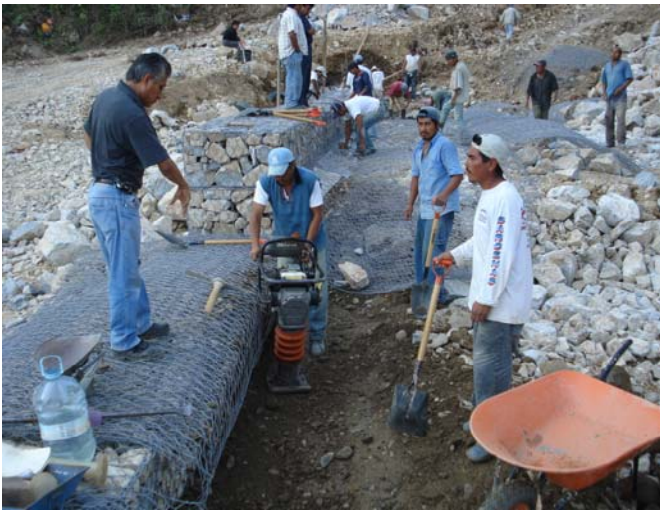
Durante la obra
